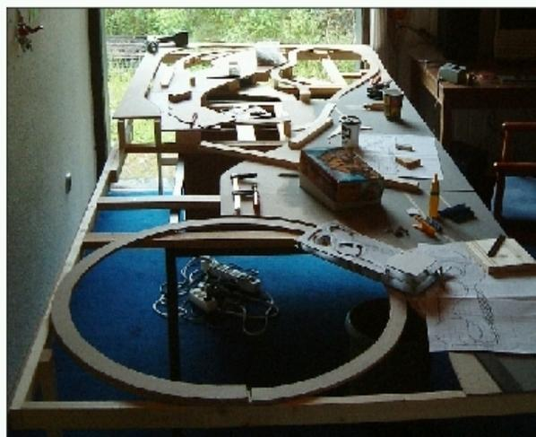
Nach und nach wurden weitere Ebenen ausgesägt, Steigungen konstruiert und Gleiswendeln eingesetzt.
